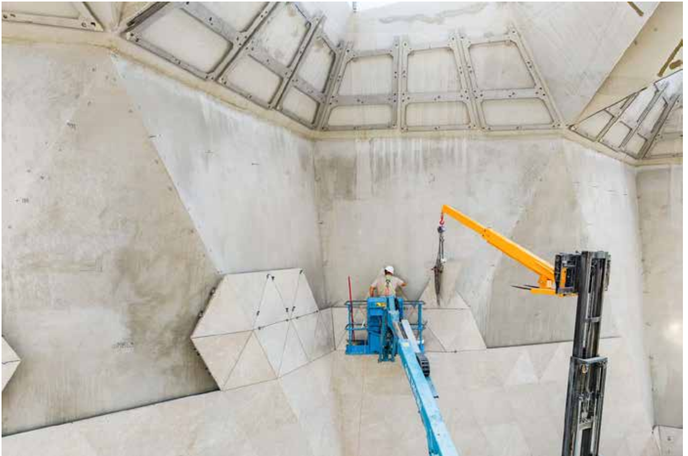
دیوارهای تاخورده زیر سازه مشبک که با سنگ محلی پوشانده شده‌اند.
