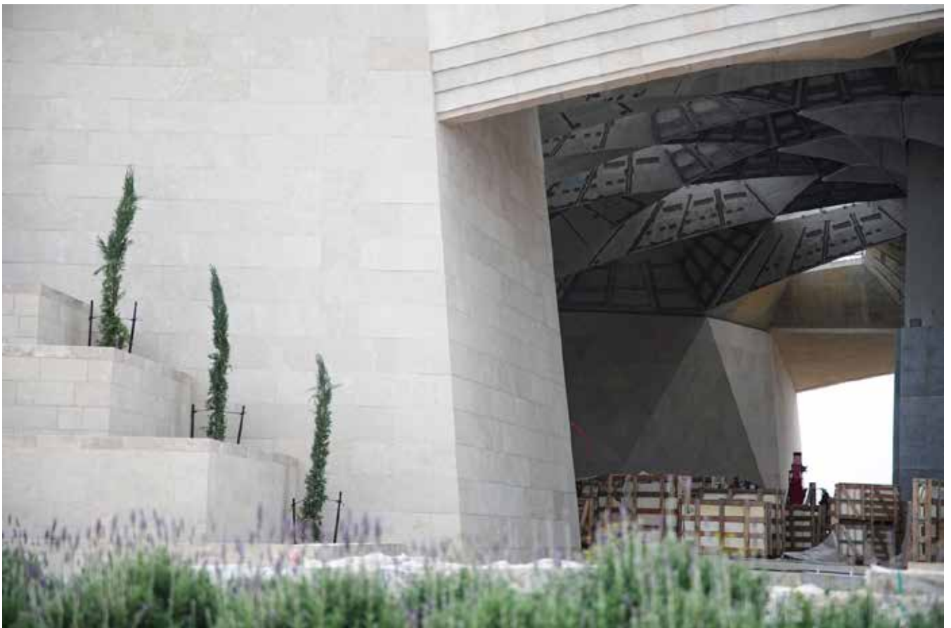
نمای بیرونی مقام حضرت عبدالبهاء، در حالی که عملیات ساخت و محوطه‌سازی ادامه دارد.
