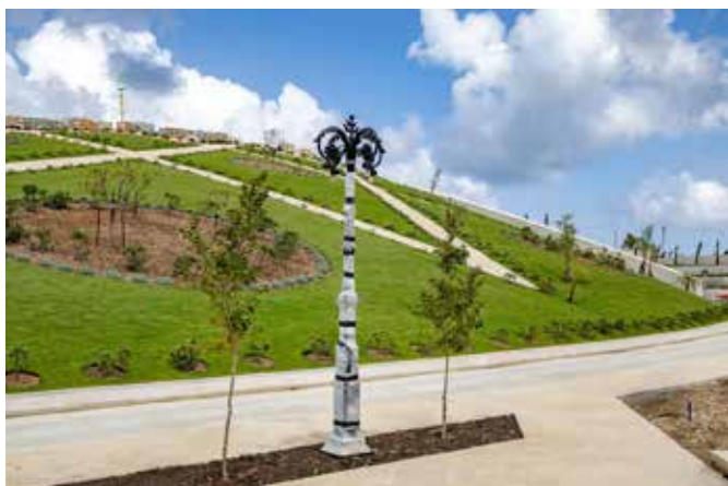
نصب تجهیزات نورپردازی در سراسر محوطه در حال پیشرفت است.
